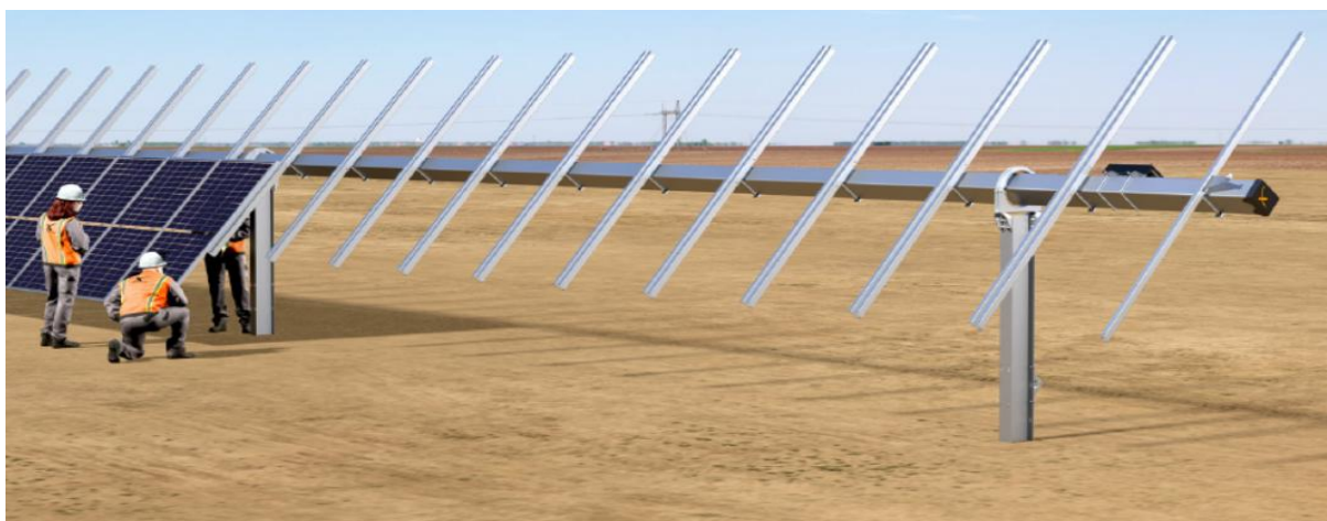
Slika br. 5. Noseća konstrukcija sa horizontalnim trakerom
