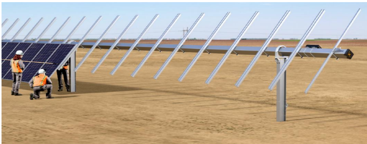
Slika br. 5. Noseća konstrukcija sa horizontalnim trakerom
