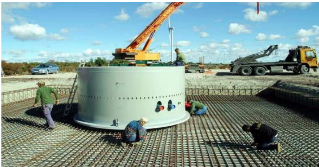
Слика 22. Изградња темеља и темељног стуба вјетроелектране.
