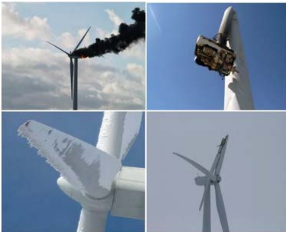
Слика 50. Могући акциденти на вјетрогенераторима (пожар – горе лијево, удар грома и прелом стуба – горе десно, пед на елисама – доле лијево, прелом елисе – доле десно).
