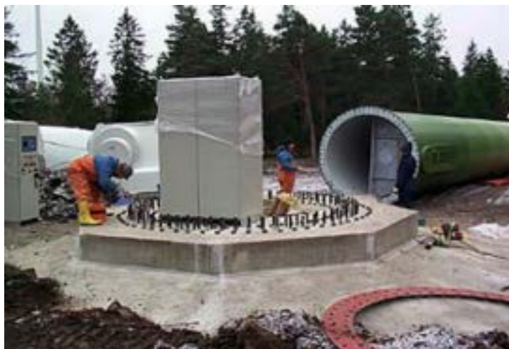
Слика 23. Монтажа вјетроелектране.
